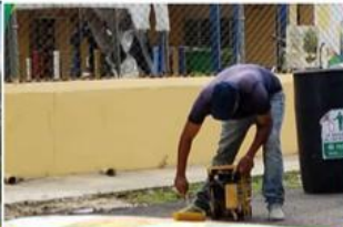
Mantenimiento a reductores de velocidad en el sector de Guaya canal.
