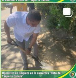
Operativo de limpieza en la carretera "Hato del Yaque la Camela"
