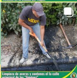
Limpieza de aceras y contenes el la calle principal de los Jimenez
