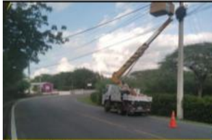
Continuidad de operativo de reparación e instalación de lámparas "LED".
