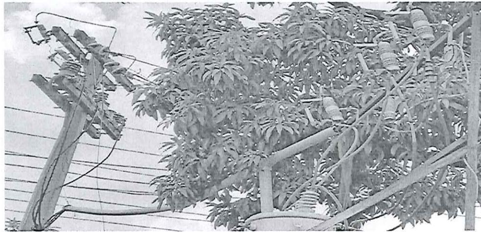
Debe realizarse con carácter de urgencia, el corte parcial del árbol que alcanza con sus ramas el tendido eléctrico de alta tensión y el transformador.
