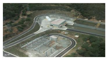
La Central Hidroeléctrica de Monción, con una capacidad instalada de 50 MW y una producción media anual de 160 millones de kilovatios hora, está destinada a suplir de energía eléctrica confiable a todas las poblaciones de la Línea Noroeste.
