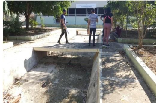
En este municipio no cuentan con un drenaje pluvial, según los moradores las aguas por la altura del terreno fluyen hacia el rio y zonas más bajas, pero ellos han implementado estos sistemas para tener una canalización del flujo de estas aguas, de esta manera limitan y controlan su recorrido, estas son canaletas ubicadas en diferentes puntos.
