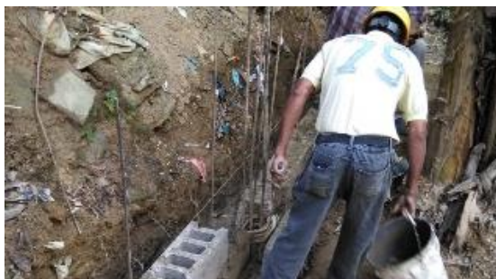
Muro de hormigón para contención de derrumbe calle Orlando Martínez, La Milagrosa.
