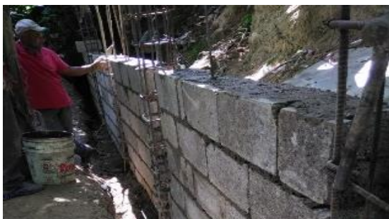
Muro de hormigón para contención de derrumbe calle Orlando Martínez, La Milagrosa.
