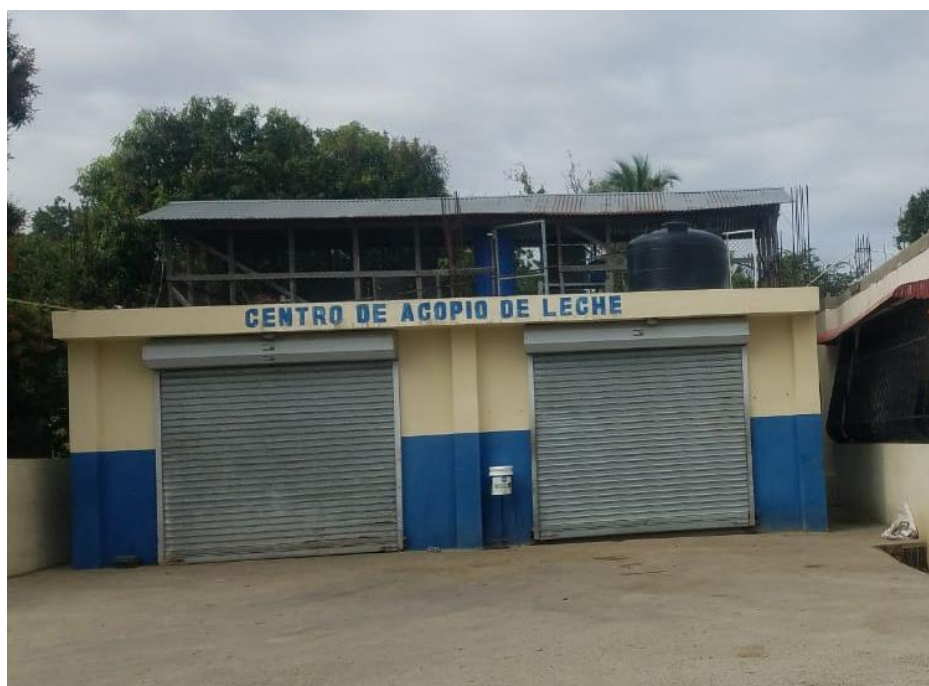
Centro de Acopio de Leche
