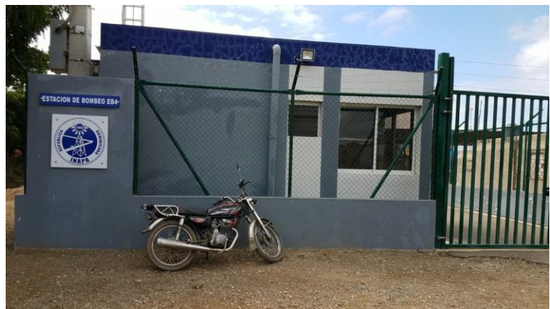
Planta de Tratamiento de Aguas Residuales
