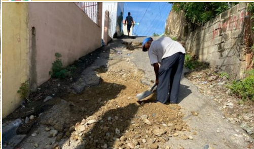
Intervención y adecuación calle primera
