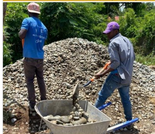
Embellcimiento de la Carretera Sajoma, construcción de aceras estampadas y cont...
