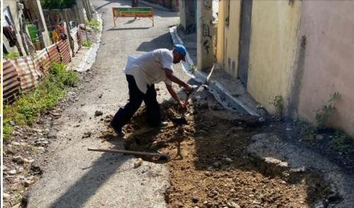
Intervención y adecuación calle primera
