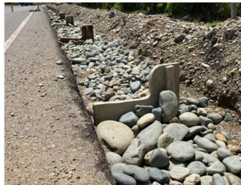
Embellcimiento de la Carretera Sajoma, construcción de aceras estampadas y cont...
