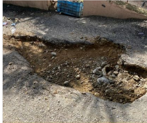
Intervención y adecuación calle primera sector La Mina
