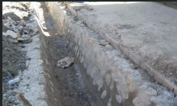
Presupuesto Participativo 2022: Construcción canaleta
