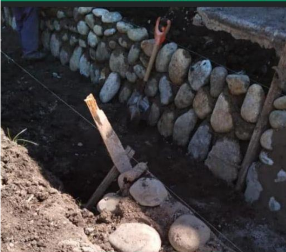
Presupuesto Participativo 2022: Construcción canaleta a cielo abierto, calle 5, Villa Fatima.
