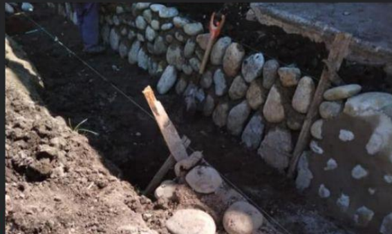
Presupuesto Participativo 2022: Construcción canaleta
