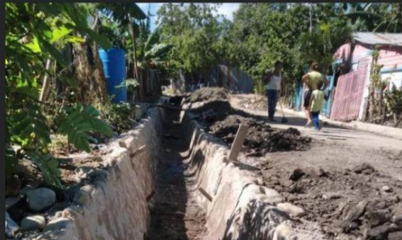
Presupuesto Participativo 2022: Construcción canaleta
