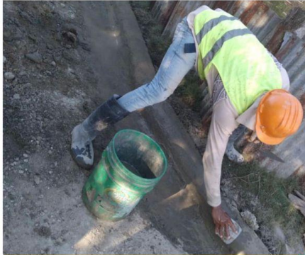
Construcción de contenes
