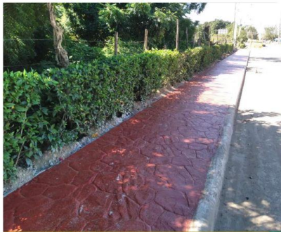
Construcción de aceras
