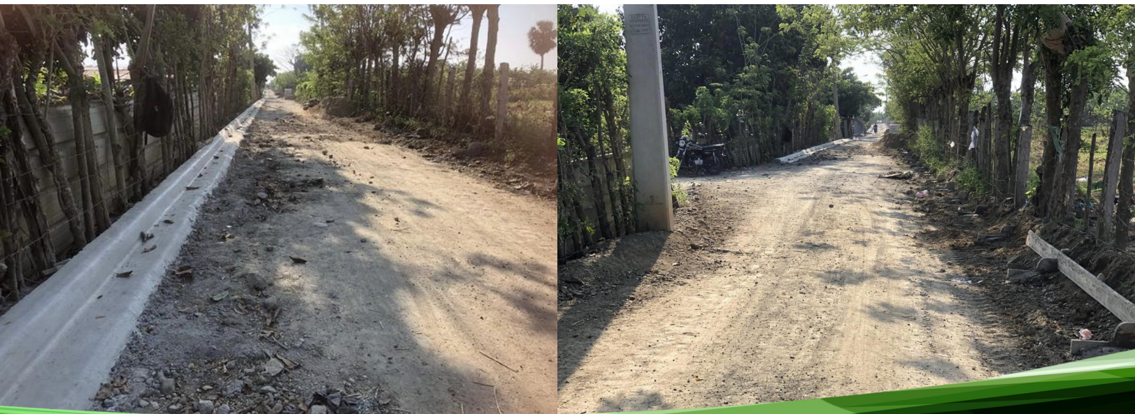
Cutupú, La Vega. Rep. Dom. Trabajos de construcción de Aceras y Contenes en el sector de la Sabana de Cutupú, zona donde nunca se había realizado dicho trabajos, nuestro alcalde acude al llamado de la población.
