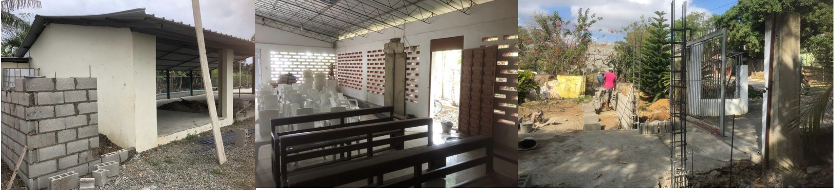
Manga Larga, Cutupú, La Vega. Rep. Dom. Proceso de reparación en la capilla San Ignacio Loyola de Manga Larga y construcción de baño y piso en el club de El Caliche.
