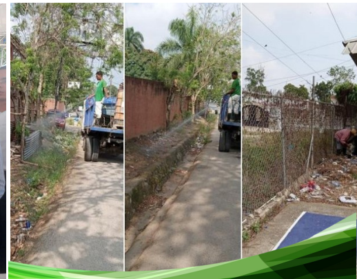
Trabajos de Aseo, limpieza y quema de hiervas en la comunidad de Bonagua y Reparadero
