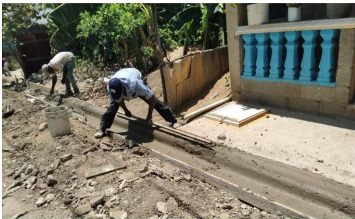
Construcción de contenes v badenes en el sector San Ramón
