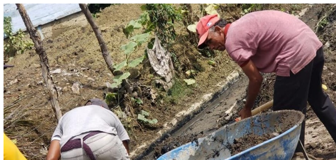
Obrero realizan los trabajos
