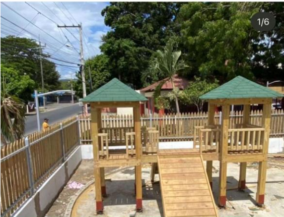
Ultima fase de construcción del parque infantil de Hato del Yaque
