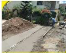
Continuación de la construcción del bache en la calle principal del sector Los Mayos, Hato del Yaque
