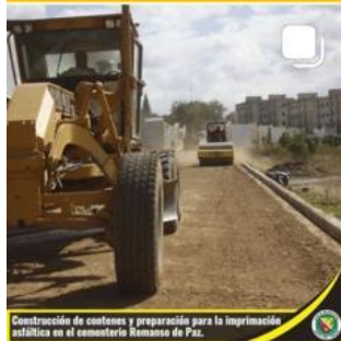
Construcción de costones y preparación para la imprimación asfáltica en el cementerio Romano de Paz.
