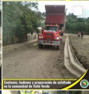
Contenes, badenes y preparación de asfaltado en la comunidad de Valle Verde
