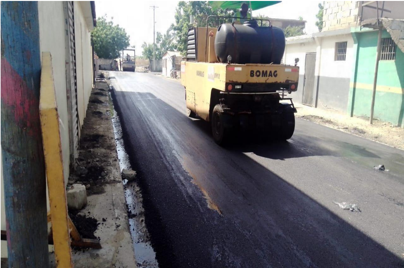
Camino vecinal Quebrada Honda Sur.
