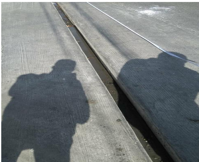
Badén en la calle Colón.
