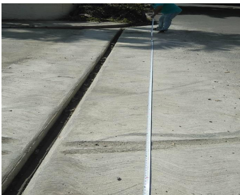
Badén en el barrio Don Bosco.
