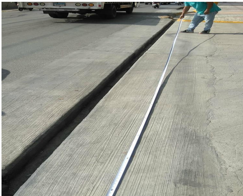
Badén frente a la Fortaleza 2 de Mayo.
