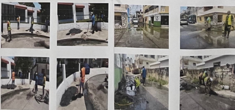
Se realizó mantenimiento a 2 imbornales de 2 parrillas.
