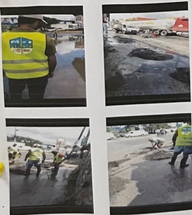
Se realizó mantenimiento a 2 Imbornales.
