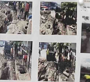
Se realizó mantenimiento a 2 Imbornales y se cuneto.
