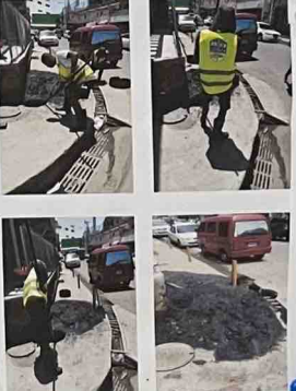
Se le realizó mantenimiento a un imbornal de 3 Parrillas.
