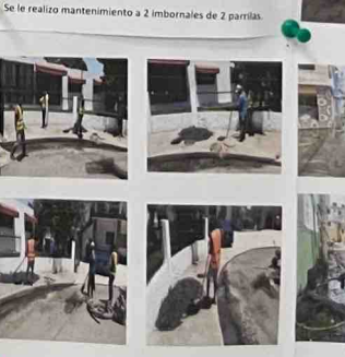
Se realizó mantenimiento a 2 Imbornales de 2 Parrillas.
