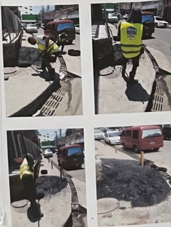
Se realizo mantenimiento a un Imbornal de 3 Parrillas.
