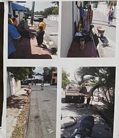
Se realizó mantenimiento a 2 Imbornales y se cuneteo.
