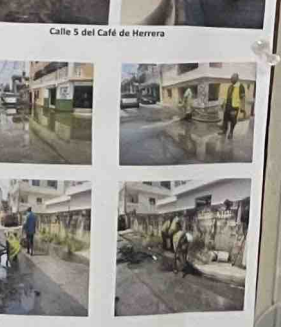
Se realizó mantenimiento a 2 Imbornales de 2 Parrillas.
