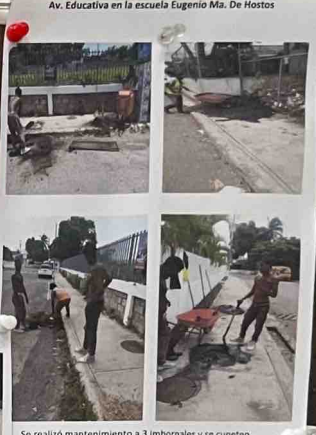
Se realizó mantenimiento a 3 Imbornales y se cuneto.
