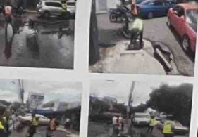
Se le realizó mantenimiento a 2 Imbornales de 2 Parrillas.
