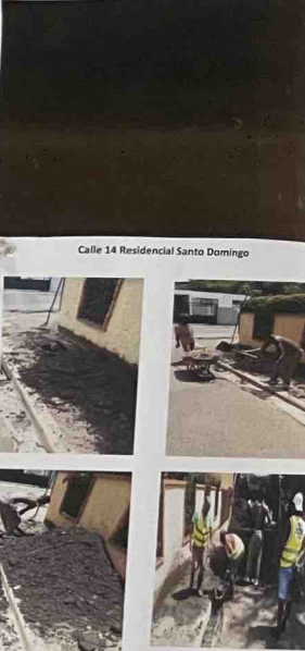
Se realizó mantenimiento a 1 Imbornal de 2 Parrillas.
