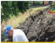
INICIAN TRABAJOS DE INSTALACION DE RED DE
