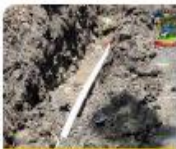
INICIAN TRABAJOS DE INSTALACION DE RED DE ABASTECIMIENTO DE AGUA EN CALLE DE LOS GUSTOS
