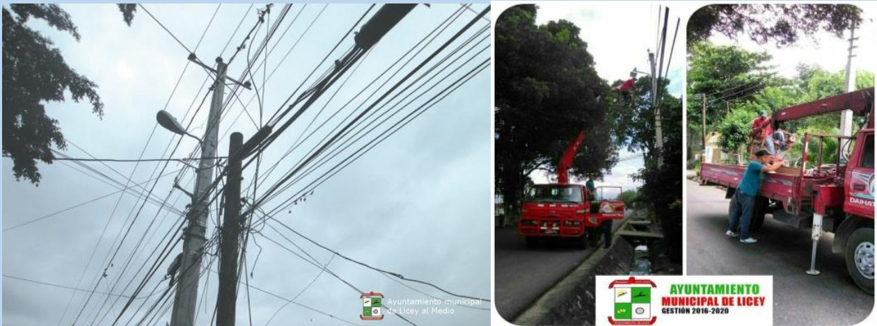
El Ayuntamiento en coordinación con EDENORTE, ejecuta un programa de mejora en la red eléctrica.
