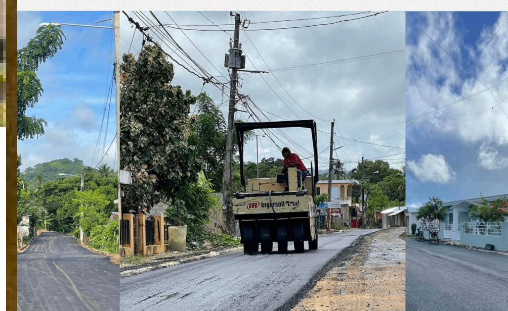
PROGRAMA DE ASFALTADO SECTOR LOS FRANCESSES
