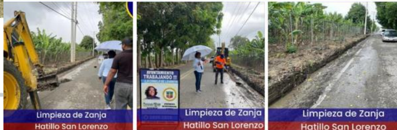
Limpieza de zanja
