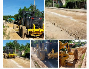
Hoy domingo aprovechando que no está lloviendo para avanzar los trabajos d... Ver más
