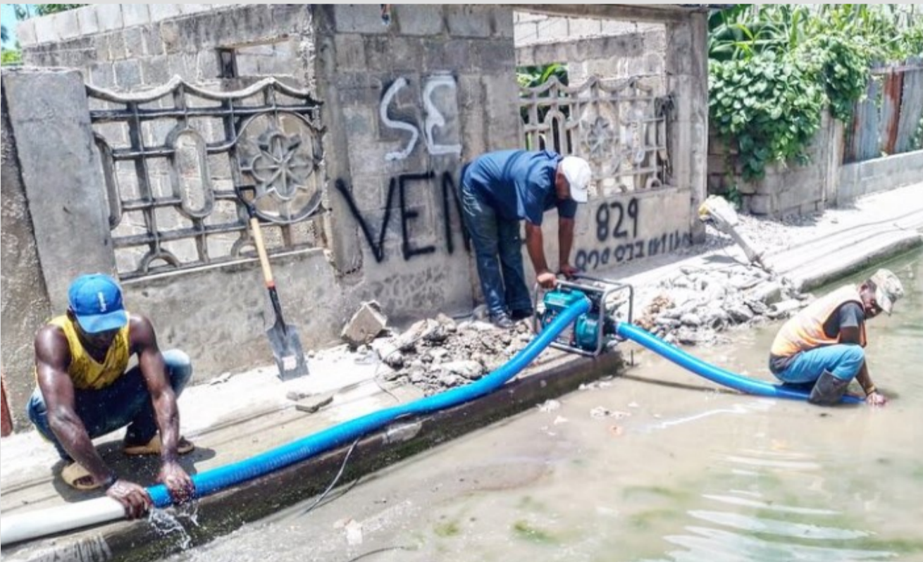
Intervención y reparación de imbornales en Villa Aura.
