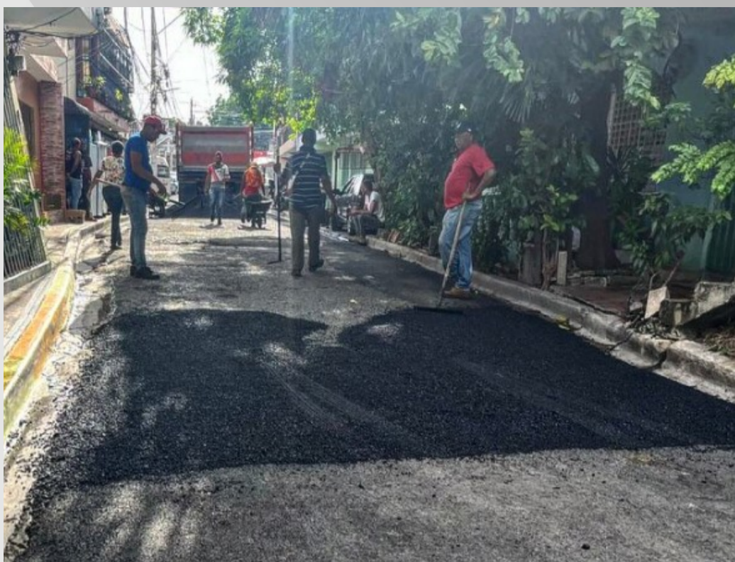
Asfaltado de la calle 4, por la zona industrial de Herrera, próximo a la Parroquia Espíritu Santo.
