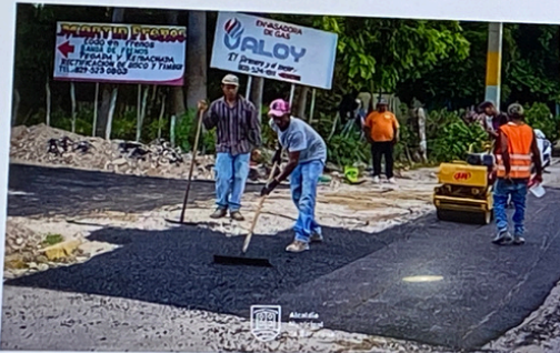
Operativo de Bacheo en Barahona
