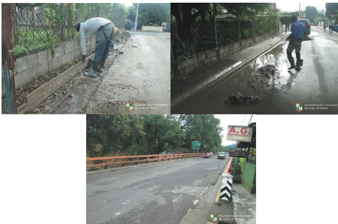
El Ayuntamiento en coordinación con MOPC, ejecutan un programa de mantenimiento vial.
