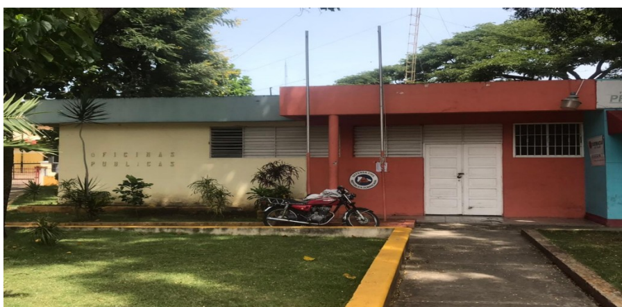
Destacamento Policial, Cuerpo de Bomberos y Defensa Civil.
