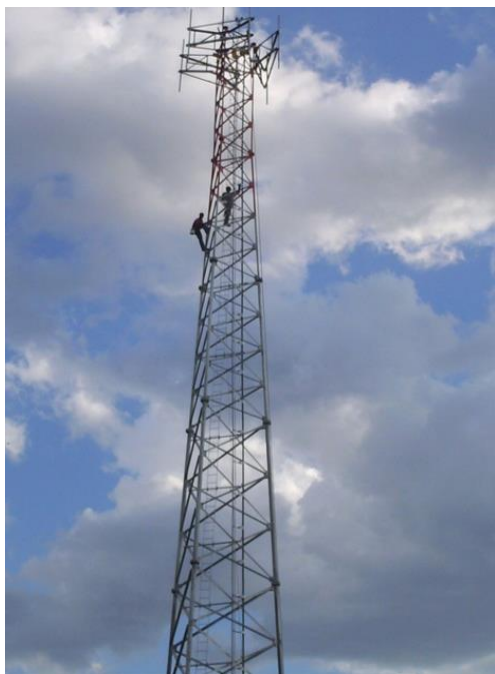
Antena Telecomunicaciones en Bánica
