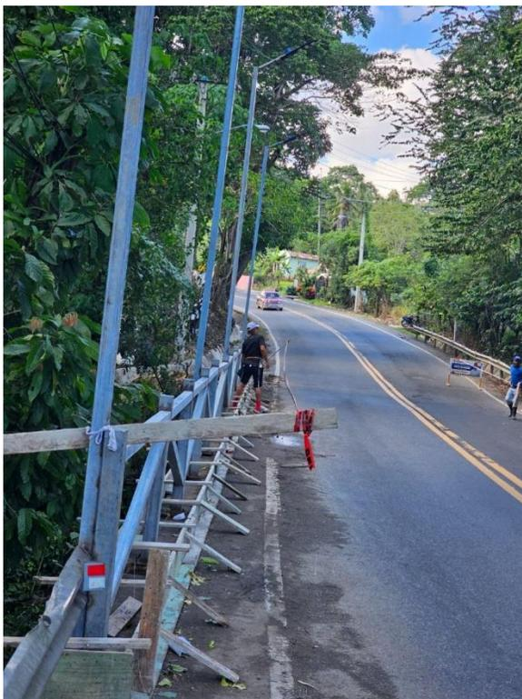
La Alcaldía de Castillo, liderada por el alcalde Faurys Vélez Victorio, inició los trabajos de restauración en el puente del Cruce de Los Lanos. Estas obras incluyen la instalación de nuevas protecciones derribadas por accidentes pasados, además de labores de limpieza y acondicionamiento en el área circundante, buscando garantizar la seguridad de conductores y peatones.
