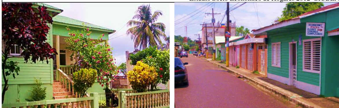
Viviendas con muros de madera
