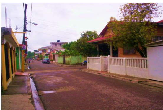
Condición calle con asfalto
