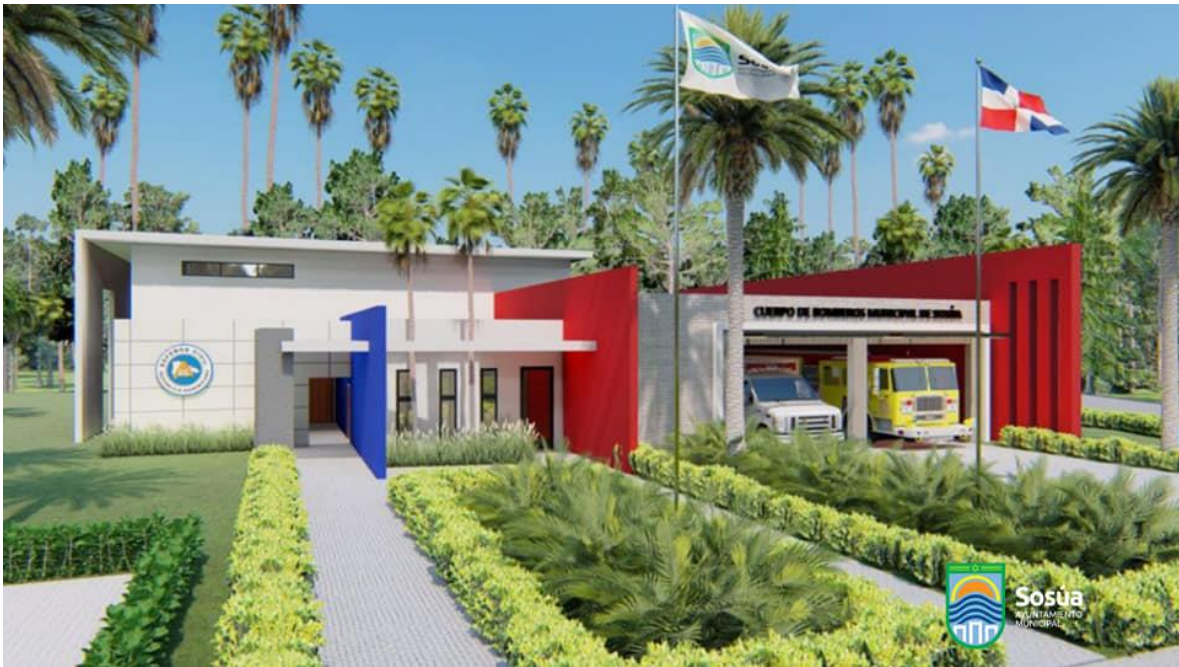
Imagen edificación bomberos y defensa civil de Sosúa.
