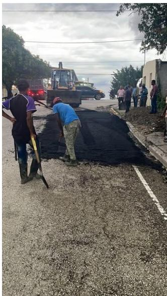
Continuando con nuestro programa de bacheos y mantenimiento de las vías de comunicación de nuestro municipio, trabajamos en el bacheo y acondicionamiento de la calle Luz Celeste Lara, en la cual también colocamos un muro para reducir la velocidad de los vehículos de motor, especialmente de los motores.
