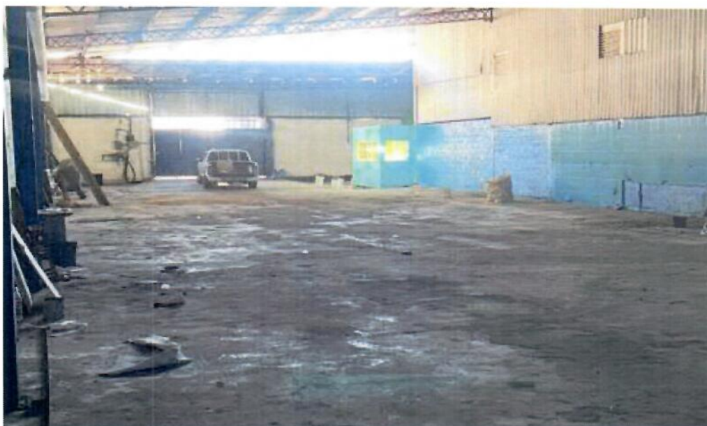
Área de parqueo
