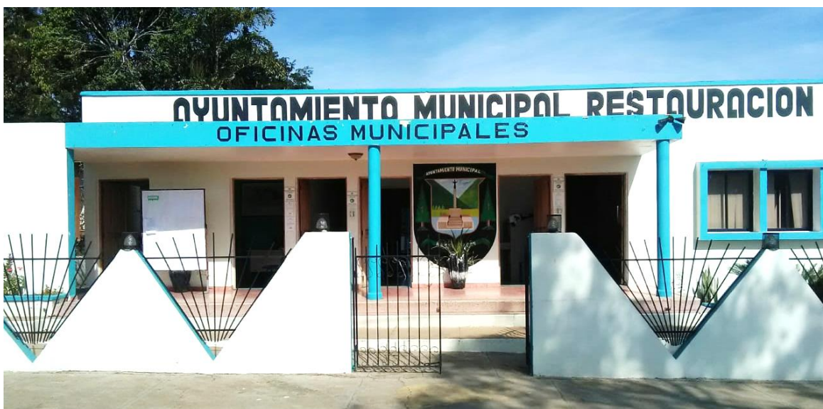
Ayuntamiento Municipal de Restauración Av. San José # 51
