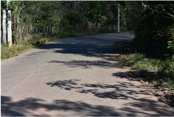
Carretera Loma de Cabrera-Restauración
