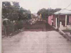
Arreglo de bacheo en el barrio Buenos Aires.
