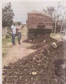
Arreglo de bacheo en el barrio los tres palmas.
