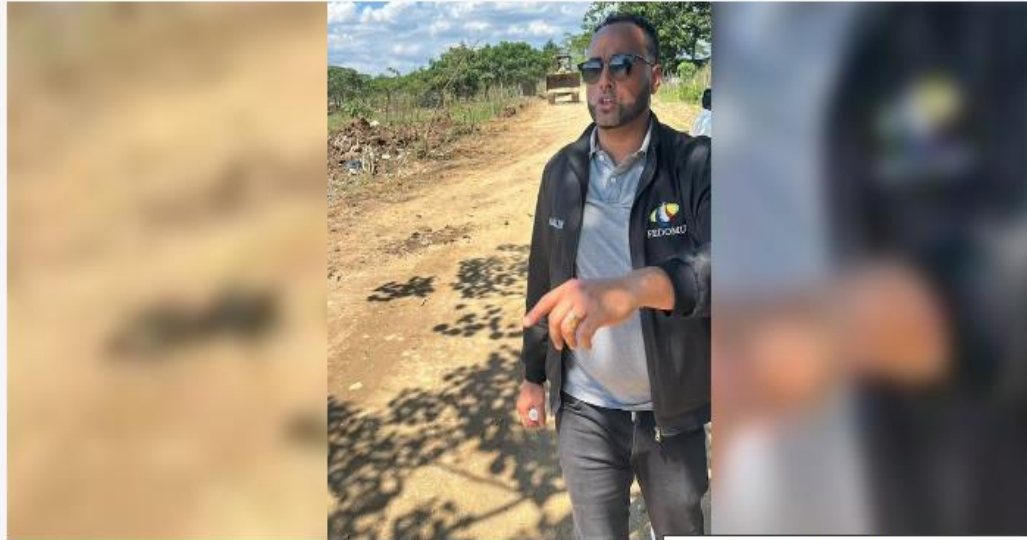
Avance trabajos Circunvalación Fantino-San Miguel.
