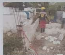
Construcción de una pared en el cementerio de los Hatillos.
