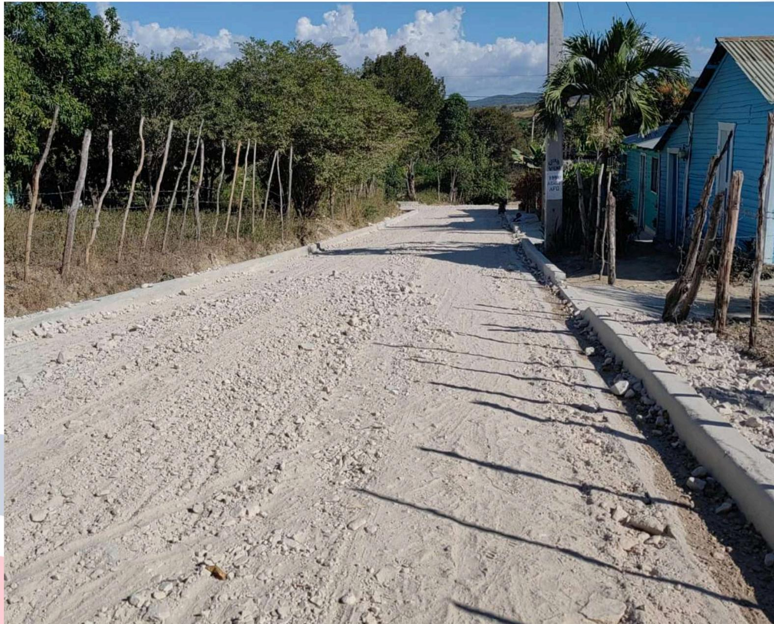
**Después:** Se nivelaron y compactaron con maquinaria, dejándolas listas para el proceso de asfaltado posterior.
