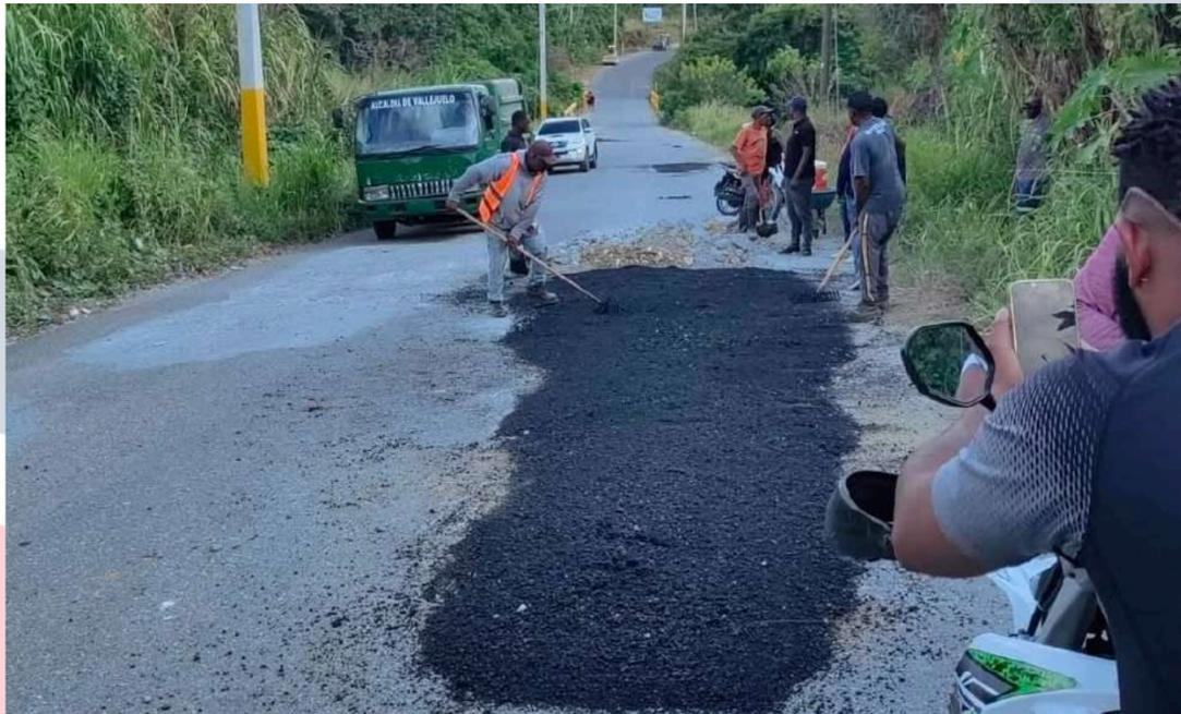
**Después:** Se aplicó mezcla asfáltica en caliente en los puntos críticos, mejorando la fluidez del transporte.
