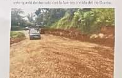
Mantenimiento del colateral del puente del Barrio de la Misagüa, en la zona de Peralvilla.
