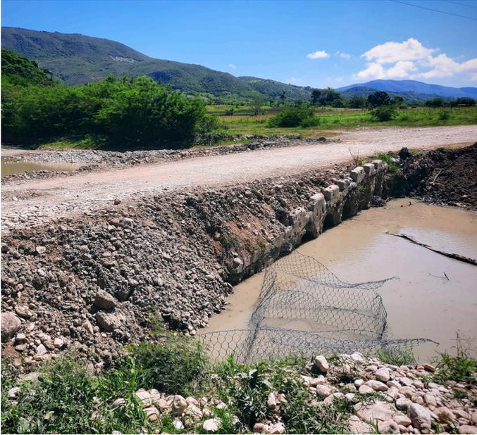
Se inició la instalación de gaviones en el área del puente de Maringüen, una acción clave para preservar la estabilidad de esta infraestructura vial, que frecuentemente se ve afectada por las crecidas del río durante la temporada de lluvias.
