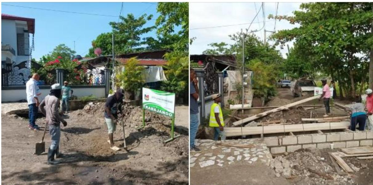
La canaleta, diseñada con estructura de blocks reforzados y forma de paso tipo puente, representa una solución funcional y duradera, pensada para resistir el flujo constante de agua y garantizar la movilidad en tiempos de lluvias intensas.
