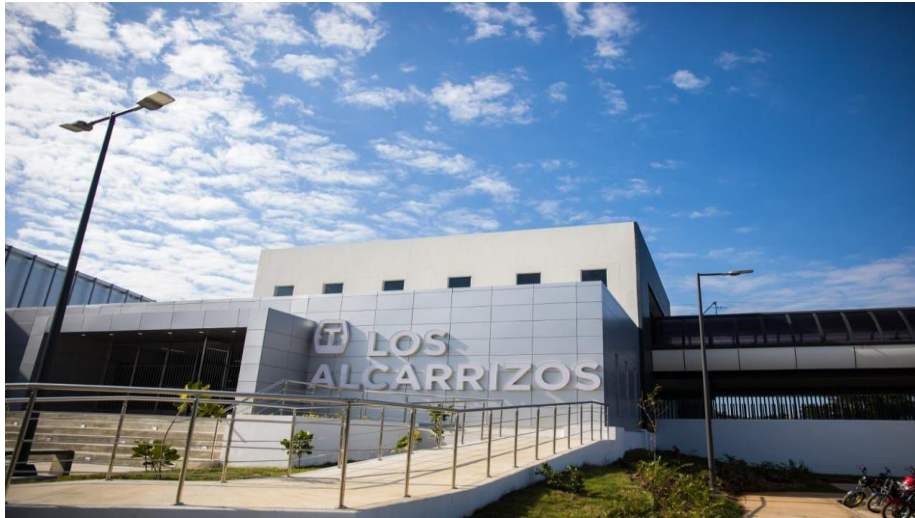
Estación principal del teleférico en la entrada de Los Alcarrizos
