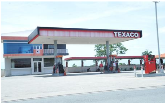
Estacion de Combustible Texaco, Rincon D.M.
