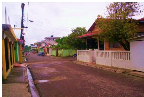
Condición calle con asfalto
