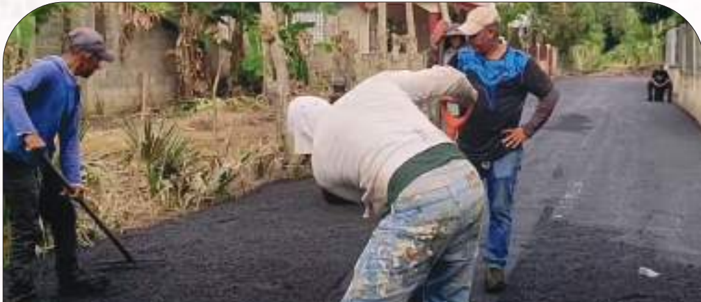
Alcalde Pedro Estrella sigue trabajando donde los demás nunca habían ido esta vez Los Flores en Las Amapolas. Calificado Y Asfaltado. Gracias al ministerio de Obras Públicas y su director provincial José Bernaldo Reinoso.
