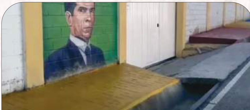
Pedro Estrella construye acera frente al Centro Educativo Onésimo Grullón en la Cuero Duro. Esta obra viene a proteger los estudiantes que a la hora de abordar los autobuses escolares los recogen frente al centro educativo.
