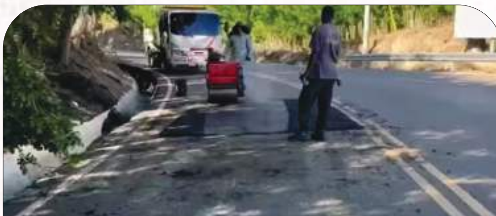
Pedro Estrella realiza operativo de bacheo en la carretera San Víctor – Jamao. Como una encomienda del Ministro de Obras Públicas y Comunicaciones, Ingeniero Eduardo Estella.
