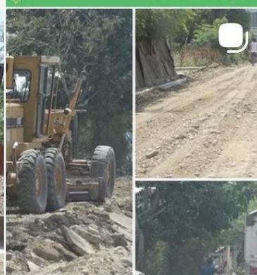
Inicio de trabajos de acondicionamiento del sector San Roque de Hato del Yaque
