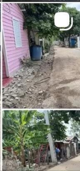
Construcción badenes sector Los Guandul presupuesto n
