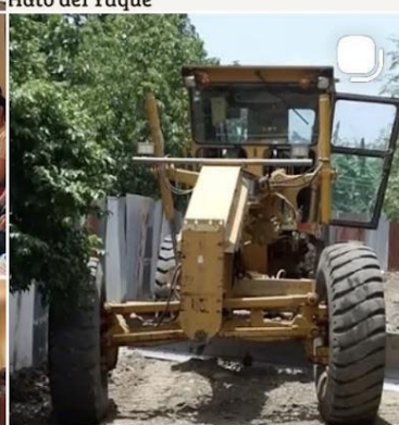
Trabajo de acondicionamiento de la Unidad Ejecutora de Hato del Yaque
