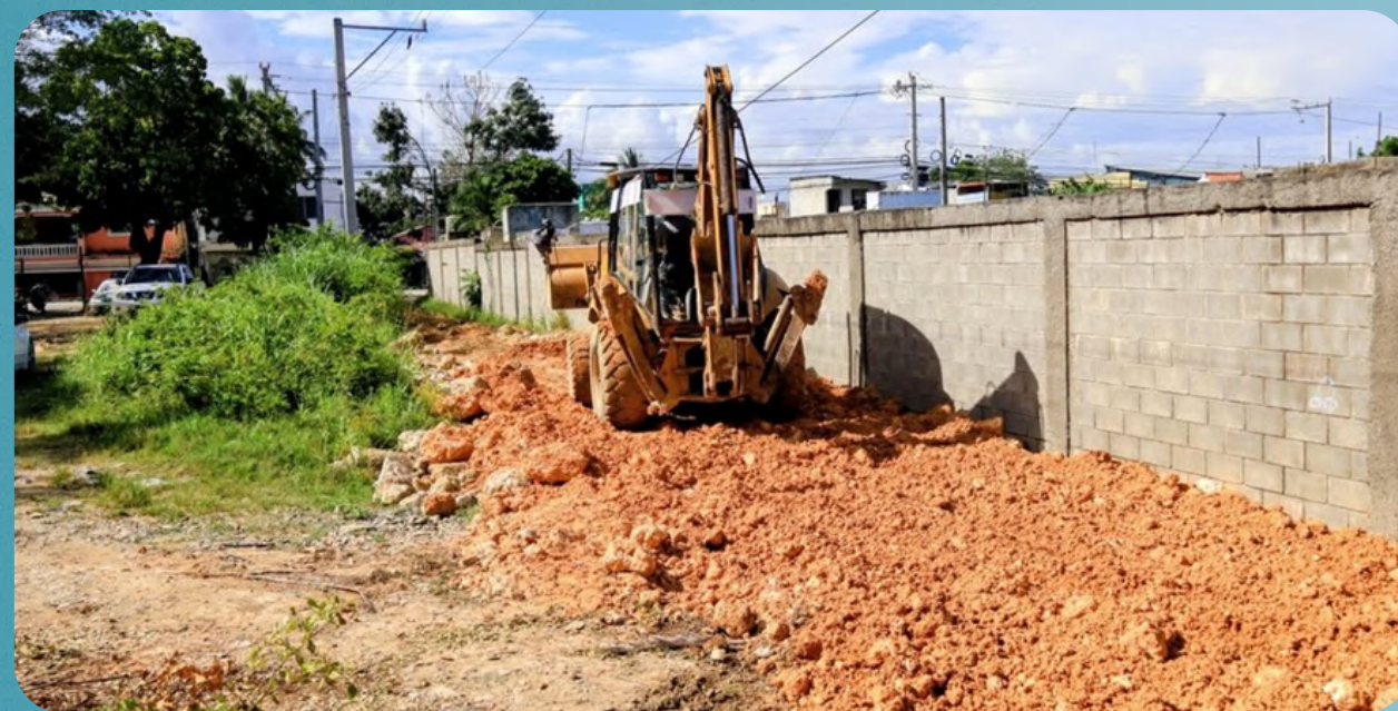
Reconstrucción calle del Cementerio
