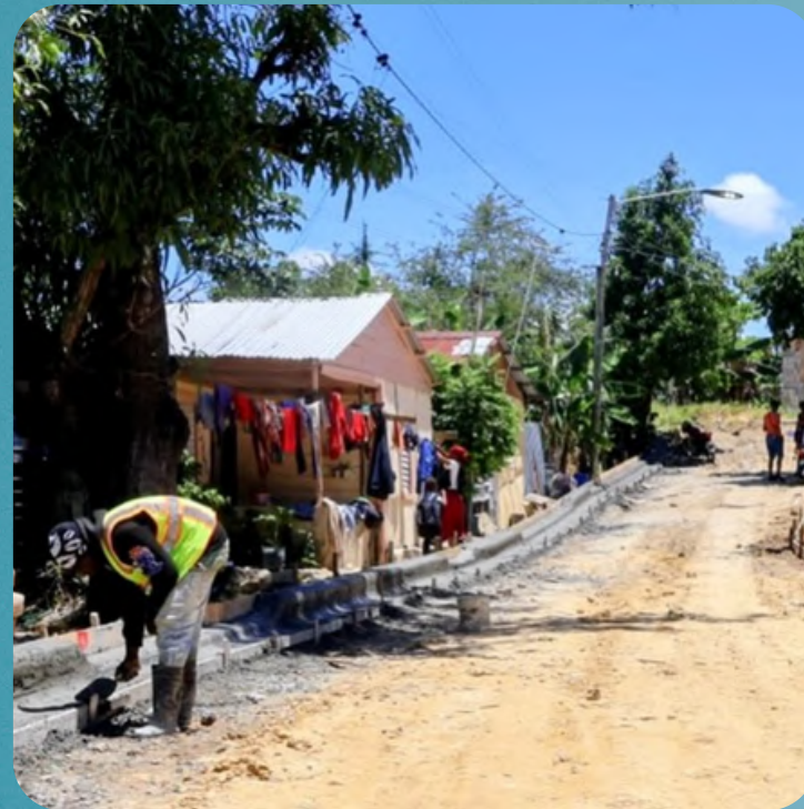
Reconstrucción de calles, aceras y contenes en Café de Herrera
