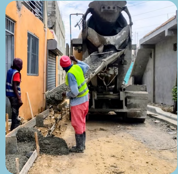
Construcción de calles, aceras y contenes Nueva Esperanza, Villa Verde
