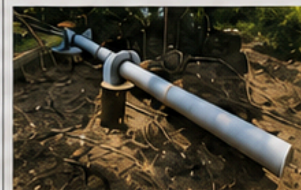
Instalación de tubería Sector El Pozo
