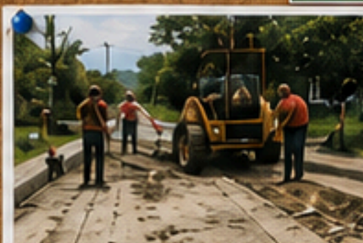
Reparación de calle La Ceiba
