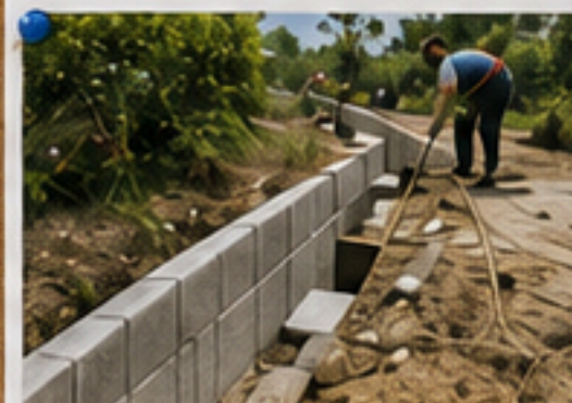
Construcción de contenes Calle Principal
