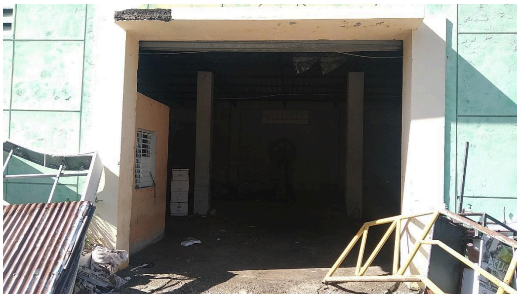
Arrea de trabajo del electricista y gomero.
