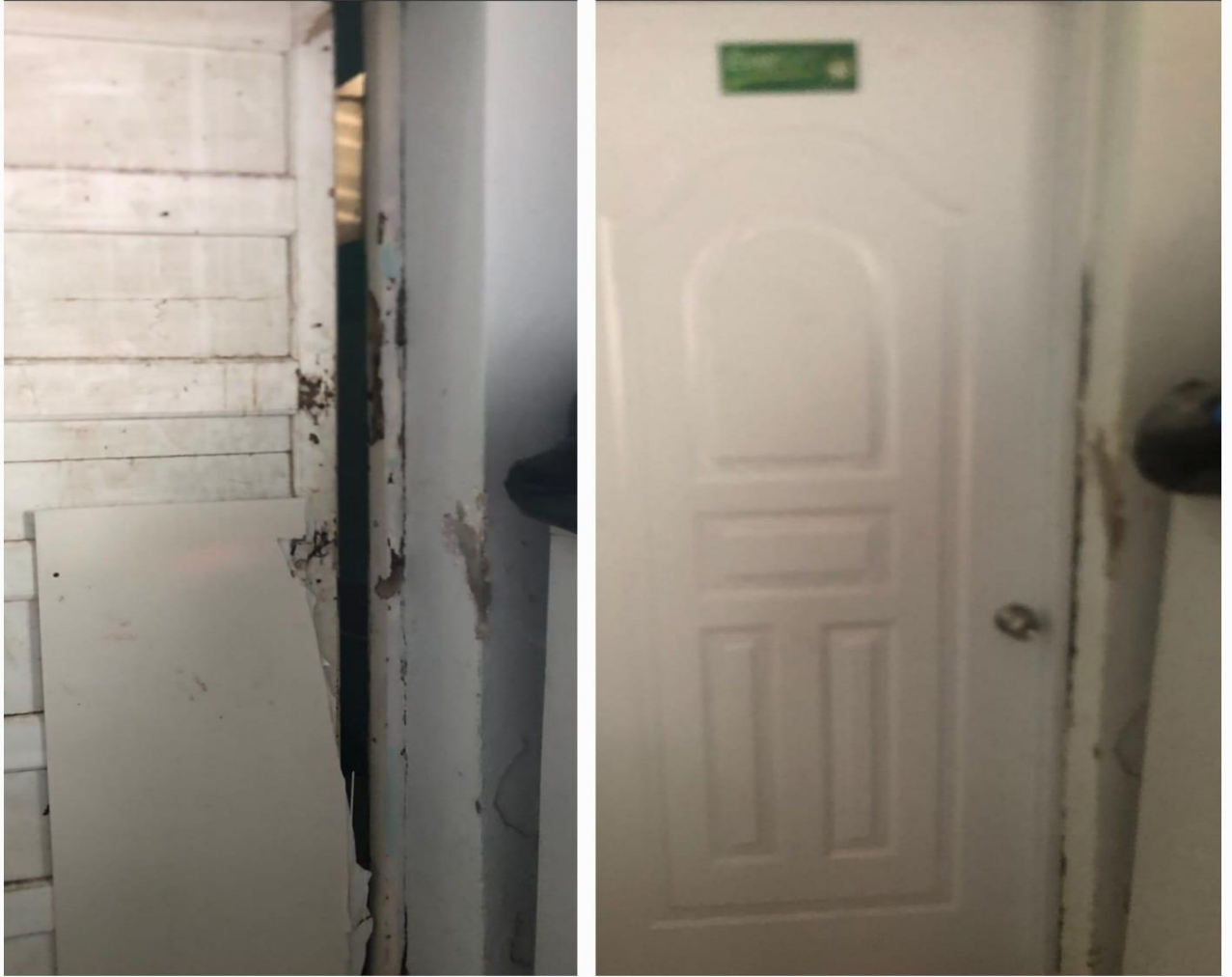
Cambio de puerta del Área de Estar del Personal de Limpieza
