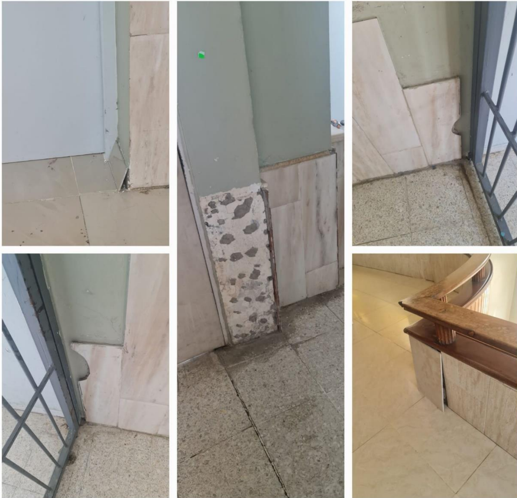
Mejoras de Paredes (Antes)
