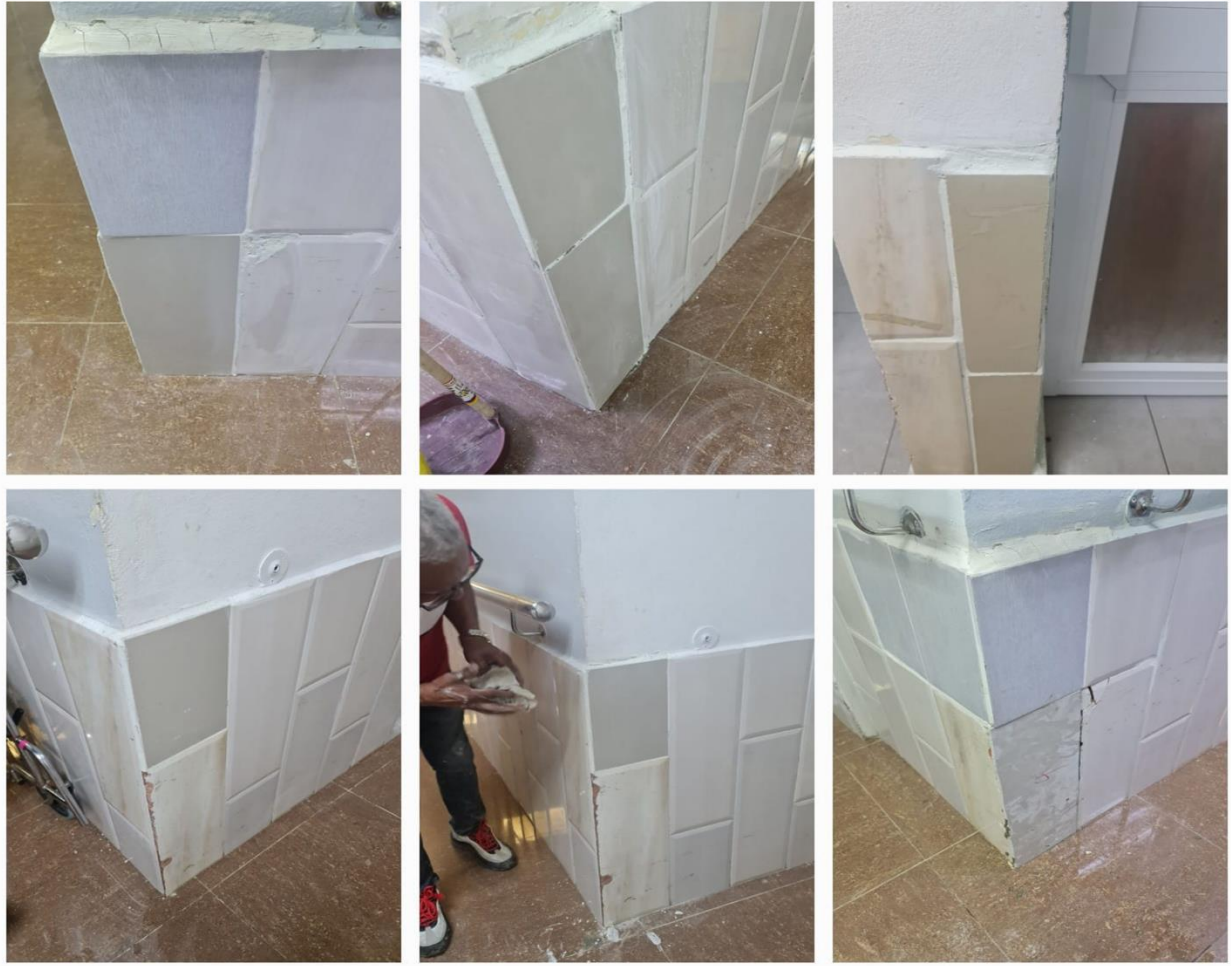
Mejoras de Paredes (Ahora)
