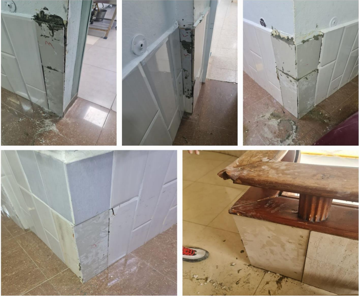
Mejoras de Paredes (Durante)
