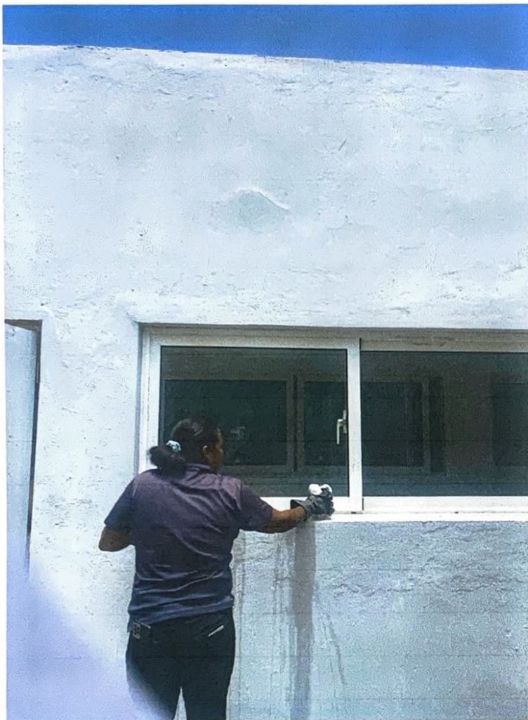
Limpieza general del exterior, paredes y ornato
